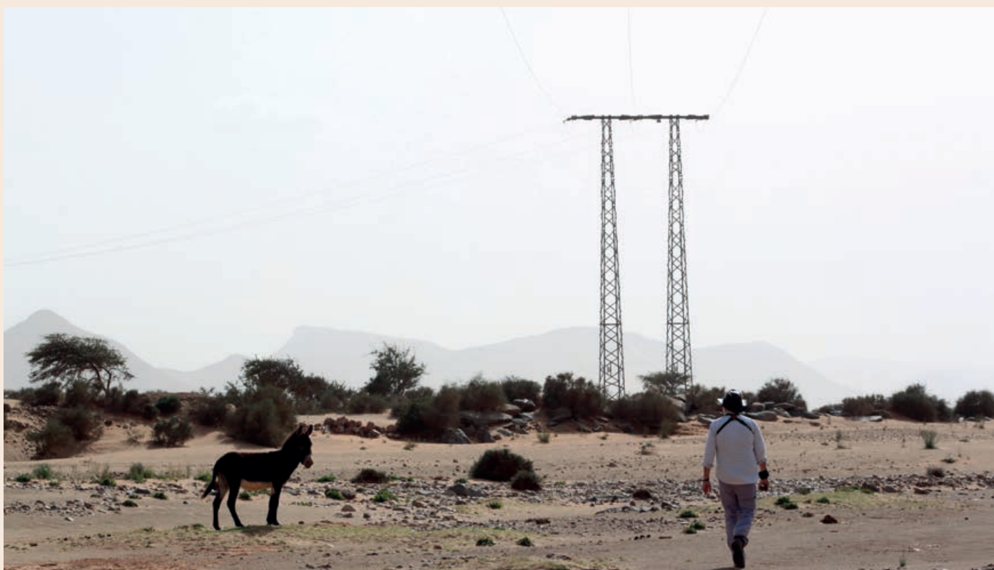
Parcours d'une ligne électrique pour repérer des éventuels cas d'électrocution et pour évaluer les pylônes, province de Tan-Tan © Helena Clavero/UICN
